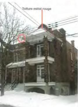
COIN TOITURE MÉTAL À REMPLACER POUR ÉVITER INFILTRATION D'EAU
