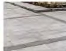
PAVÉS DE BÉTON PREFABRIQUÉS
