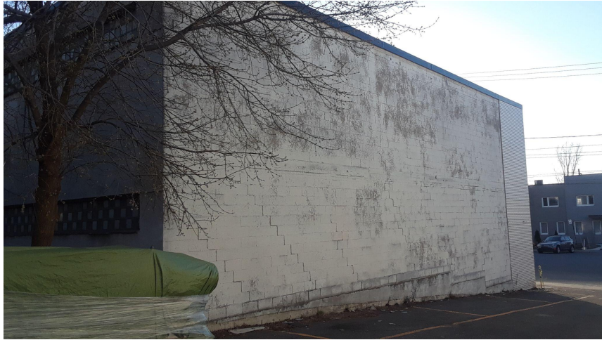
Mur latéral nord-est
