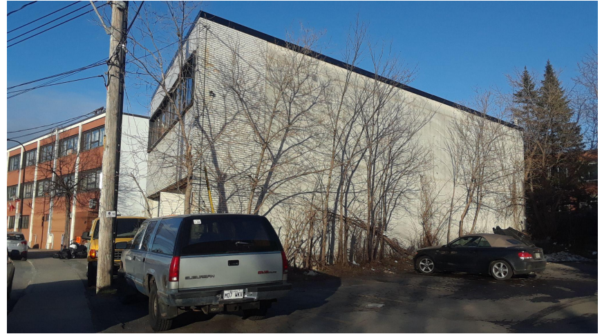
Mur latéral sud-ouest
