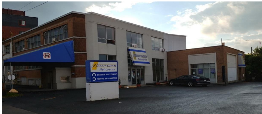
Photo 2. Façade du bâtiment existant à démolir.
