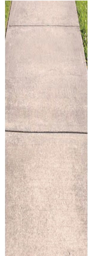
BÉTON COULÉ POUR LES CHEMINS DE CIRCULATION PIÉTONNE
