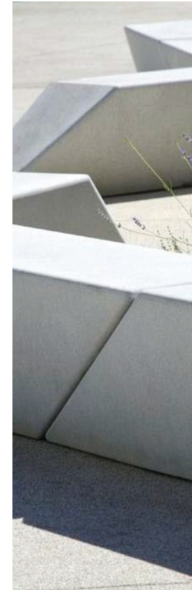
BÉTON COULÉ POUR LES BANCs
