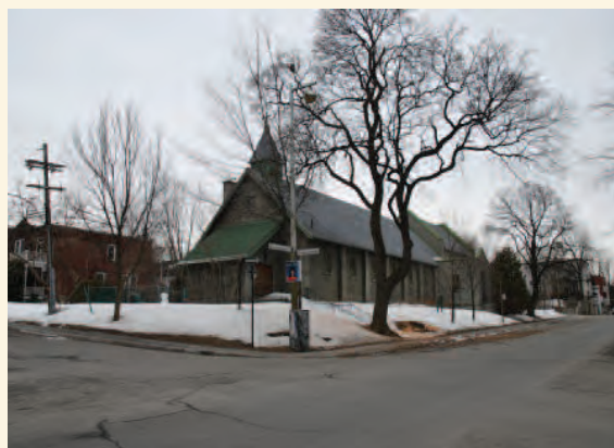
Vue du site depuis l'angle des avenues Beaconsfield et Notre-Dame-de-Grâce (Source : Ville de Montréal, mars 2014)
