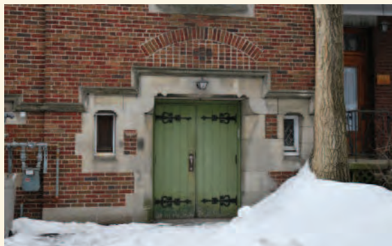
Détail de la façade du centre communautaire (Source : Ville de Montréal, mars 2014)
