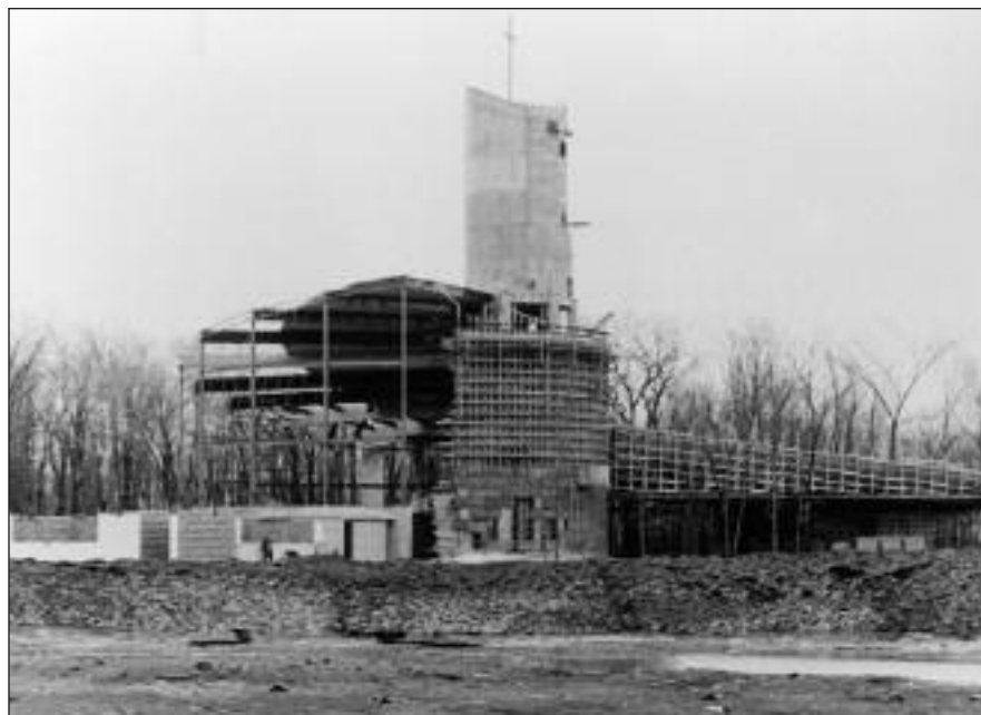
Construction de l'église Notre-Dame d'Anjou (1959). Source : Raymond Vanier
