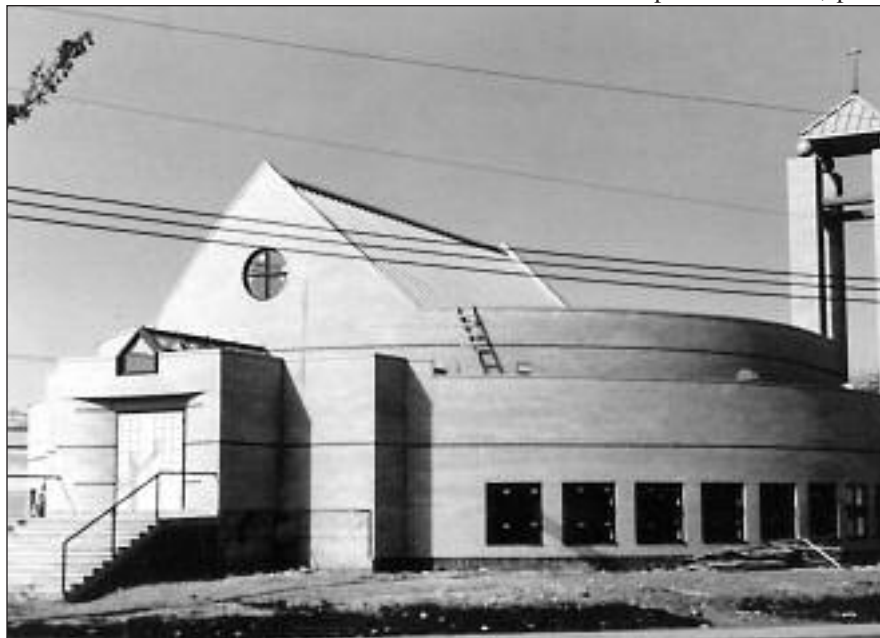
Église Saint-Conrad en voie de parachèvement (1985). Source Raymond Vanier
