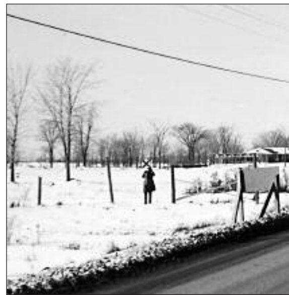
Montée Saint-Léonard avec vue sur l'échangeur Anjou en constr
