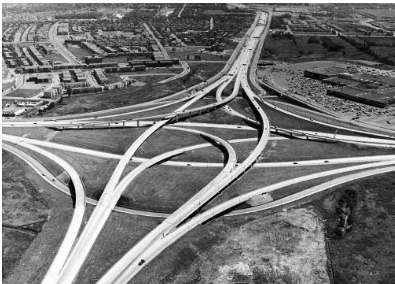
Échangeur Anjou complété: à droite, les Galeries d'Anjou, au centre, montée Saint-Léonard et à gauche, le secteur sud-est de la ville. Source : Anjou
