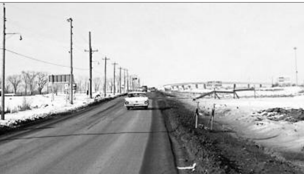
Construction vers 1964. Source : Anjou
