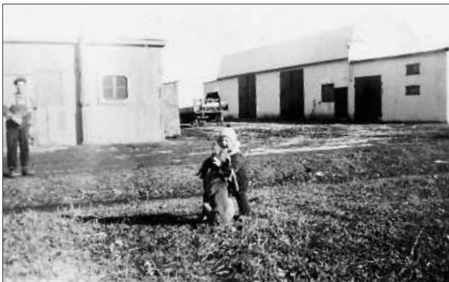
Grange de M. Trefflé Léonard. Le puits se trouve dans la petite cabane. Source : Raymond Vanier
