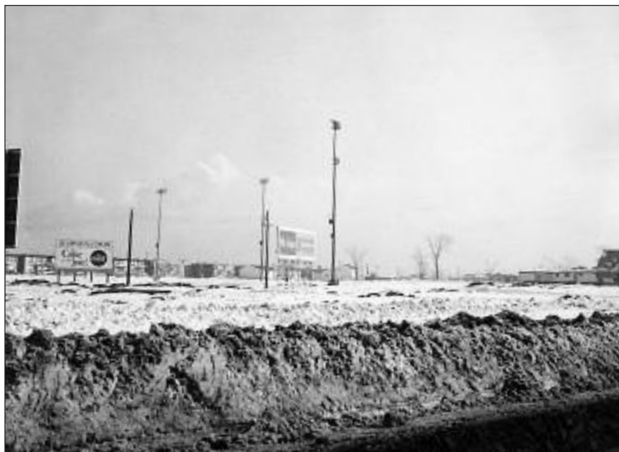
Montée Saint-Léonard, côté est; terrain prêt pour la construction. Source : Anjou
