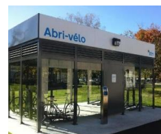
Source : STM. Abri-vélo
