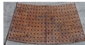
Source : Ville de Montréal, Guide d'aménagement des rues de Montréal. Tuile podotactile
