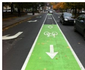
Source : Thermo-Design, Marquage de bande cyclable sur rue à Montréal, rue du Square-Victoria
