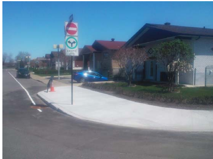
Figure 3. Saillie de trottoir sur l'avenue André-Ampère
