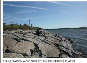
STABILISATION AVEC STRUCTURE DE PIERRES PLATES
