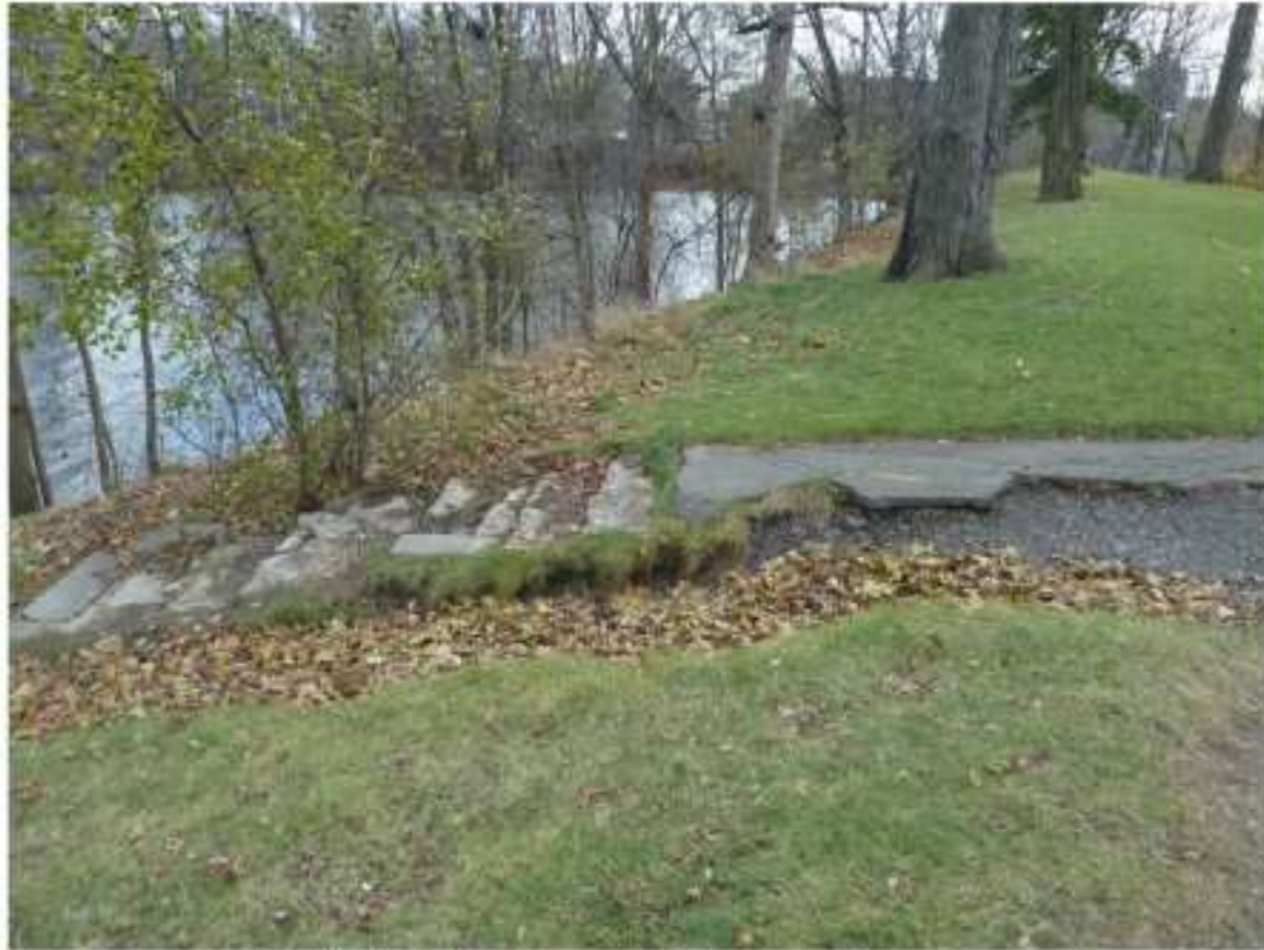
ESCALIER EXISTANT À RÉNOVER
