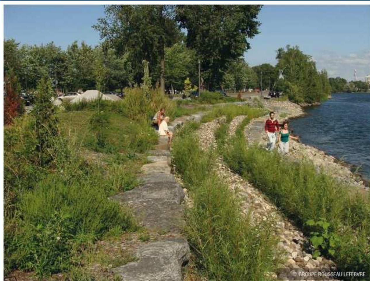
STABILISATION DE LA BERGE AVEC ENROCHEMENT ET PLANTATIONS
