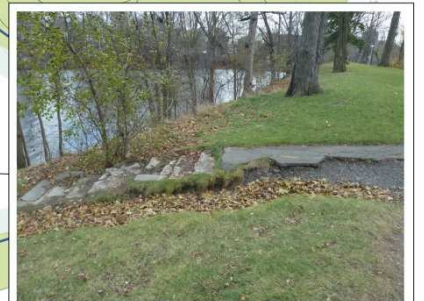
ESCALIER EXISTANT À RÉNOUVER
