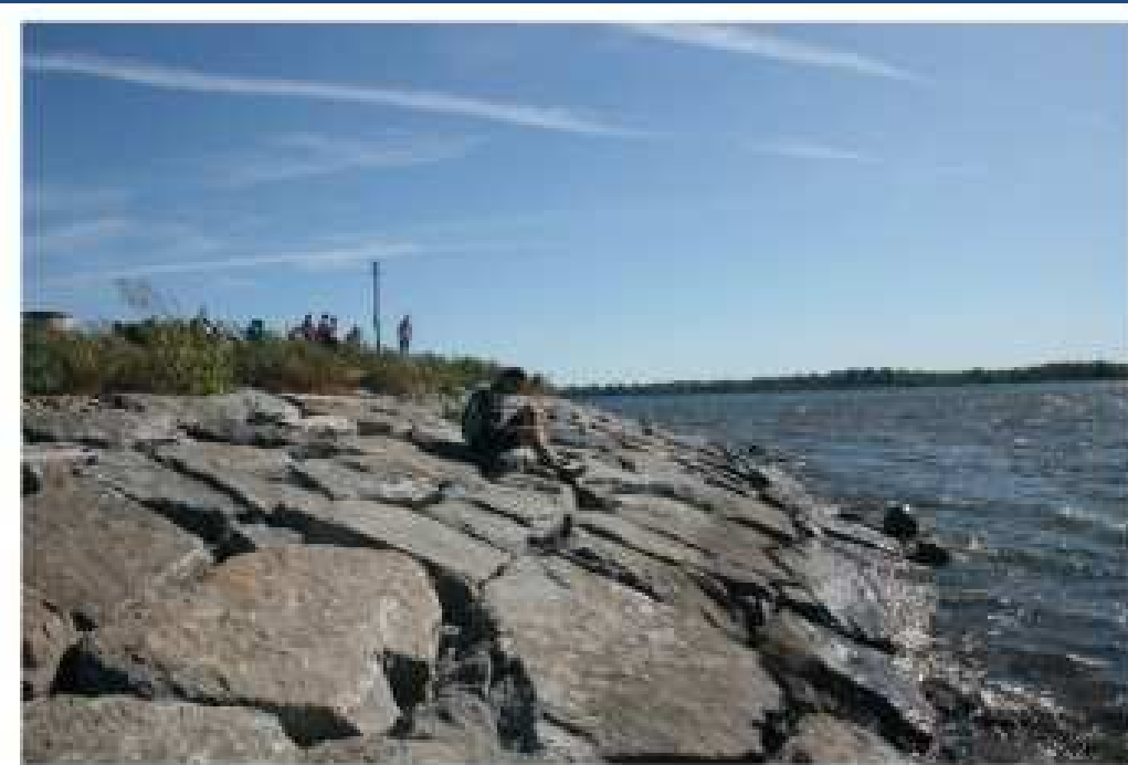
STABILISATION AVEC STRUCTURE DE PIERRES PLATES
