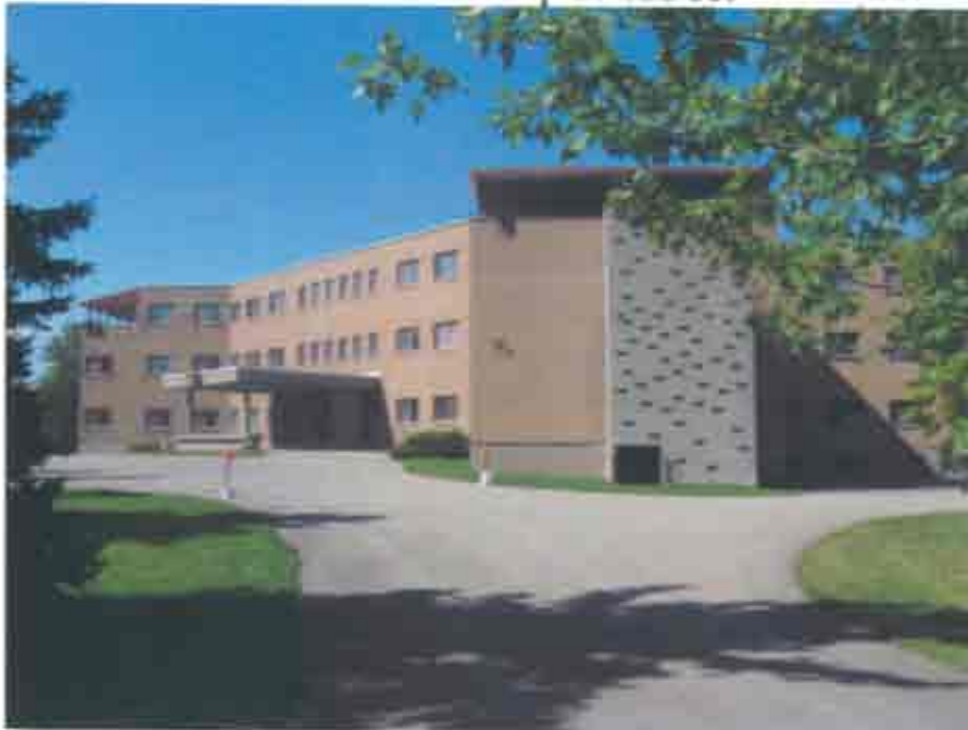
Arrondissement de Pierrefonds-Roxboro Rue Julie 17 151 rue Julie façade sud est
