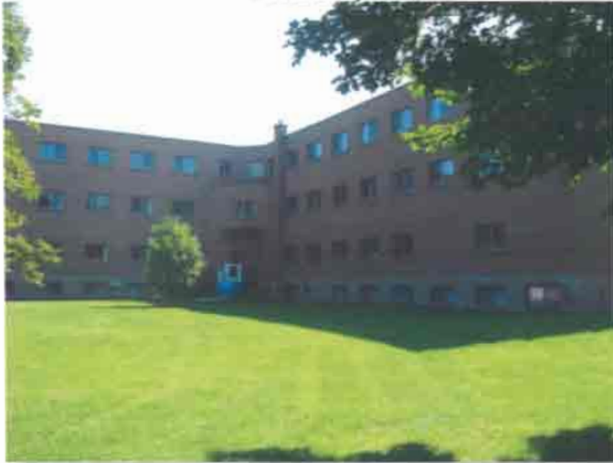
Arrondissement de Pierrefonds-Roxboro Rue Julie 17 151 rue Julie façade nord
